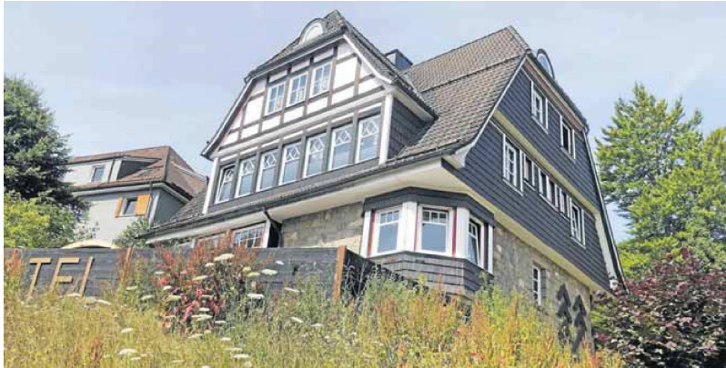
Im Juli 2021 nach Sanierung und Umbau eröffnet, ist das Braunlager Hearts-Hotel zeitgemäß gedämmt. Der Gasverbrauch zum Heizen lässt sich also nicht ohne Komforteinbußen bei der Temperatur senken, sagt Hotelier Meik Lindberg. Foto: Christian Franz
